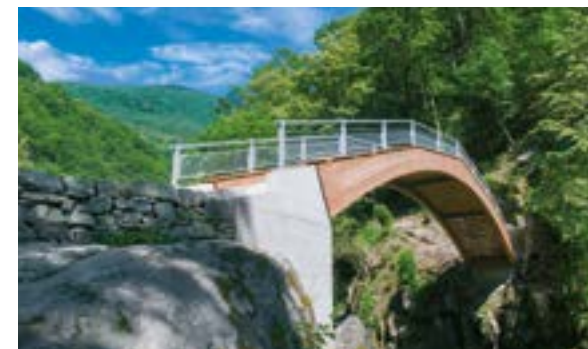
Brücke über Isorno, Loco-Niva
