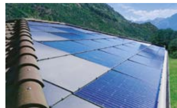
Solarpaneele können in die Baustruktur integriert werden.
